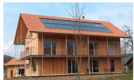
Auch in Mehrfamilienhäusern kann mit einer thermischen Sonnenenergieanlage, optimaler Wärmedämmung und passiver Sonnenenergienutzung ein sehr geringer Fremdenergiebedarf erzielt werden.
