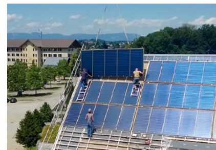
← Baufortschritt der Mehrfamilienhäuser im Januar 2015 ↑ Montage der Kollektoren ↓ Mit dem Innenausbau und der Isolation des Dachgeschosses haben wir Ende 2014 begonnen.
