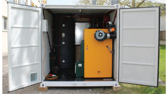
Mobile Pelletheizung mit Swiss Solartank und integriertem Pelletlager
