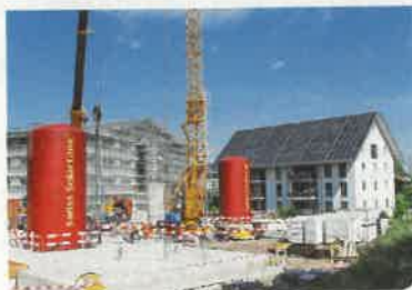
► Standardowy zbiornik ma średnicę 3 m i wysokość nieprzekraczającą 12 m. Jego masa zależy od powierzchni wymienników oraz liczby i wielkości bojlerów na c.w.u. i może przekroczyć 8 t
