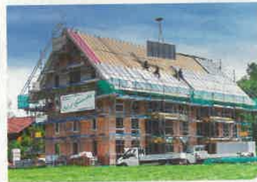
► Na połaciach dachu zamocowano sztywne poszycie z płyt drewnopochodnych. Stanowiły podłoże, na którym montowano kolektory
