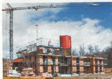
► Kondygnacje są przedzielone stropami żelbetowymi typu filigran. Prefabrykaty montowano dźwigiem, dosuwając do zbiornika, który przechodzi przez wszystkie kondygnacje, aż do poddasza nieużytkowego
