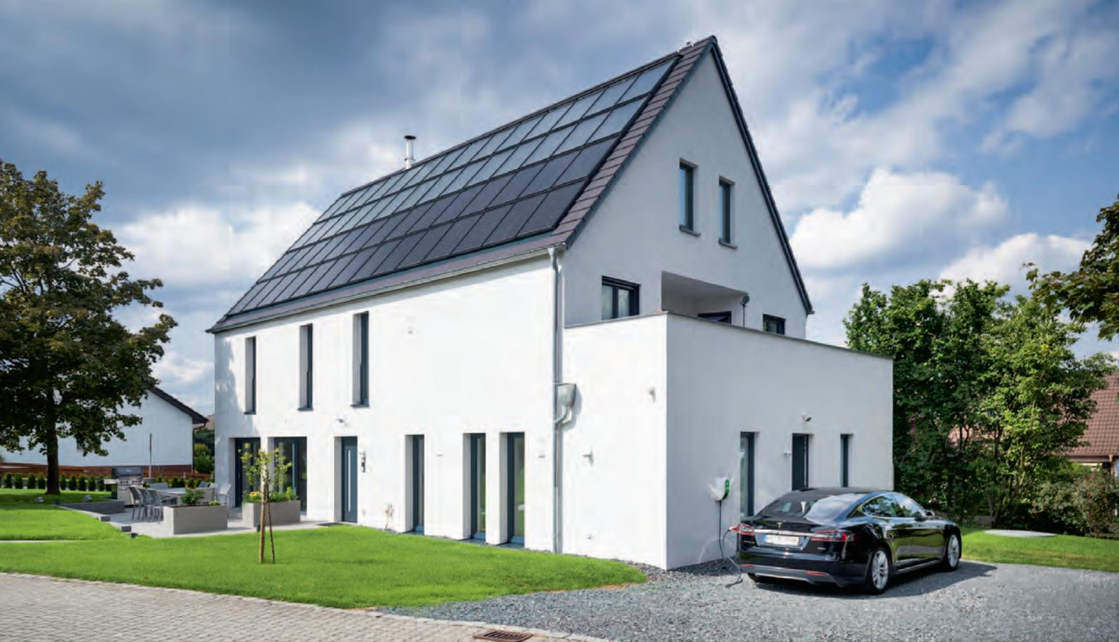
In Sonnenhäusern der neuen Generation werden Solarthermie- und Photovoltaikanlagen kombiniert, um hohe Autarkie bei Wärme, Strom und Elektromobilität zu erzielen. FOTO: GEMEINHARDT AG / UDO GEISLER
