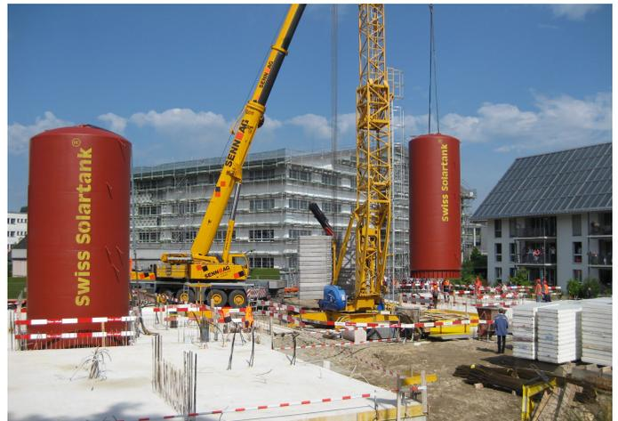
2013: Hier wird gerade der 108-m<sup>3</sup>-Speicher für das mittlere solarbeheizte Mehrfamilienhaus versetzt.
