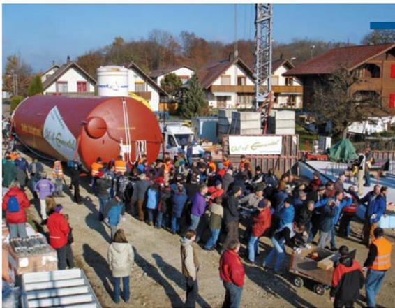
Figure 15 e 16 - Trasporto e posizionamento del serbatoio di accumulo del calore stagionale Swiss Solartank® da 205 m³
