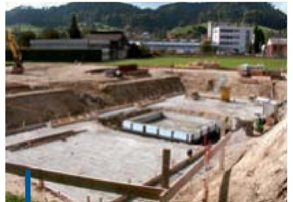
Figura 14 - Costruzione del primo condominio solare con vista dell'alloggiamento centrale per il serbatoio di accumulo del calore stagionale Swiss Solartank® da 205 m³
