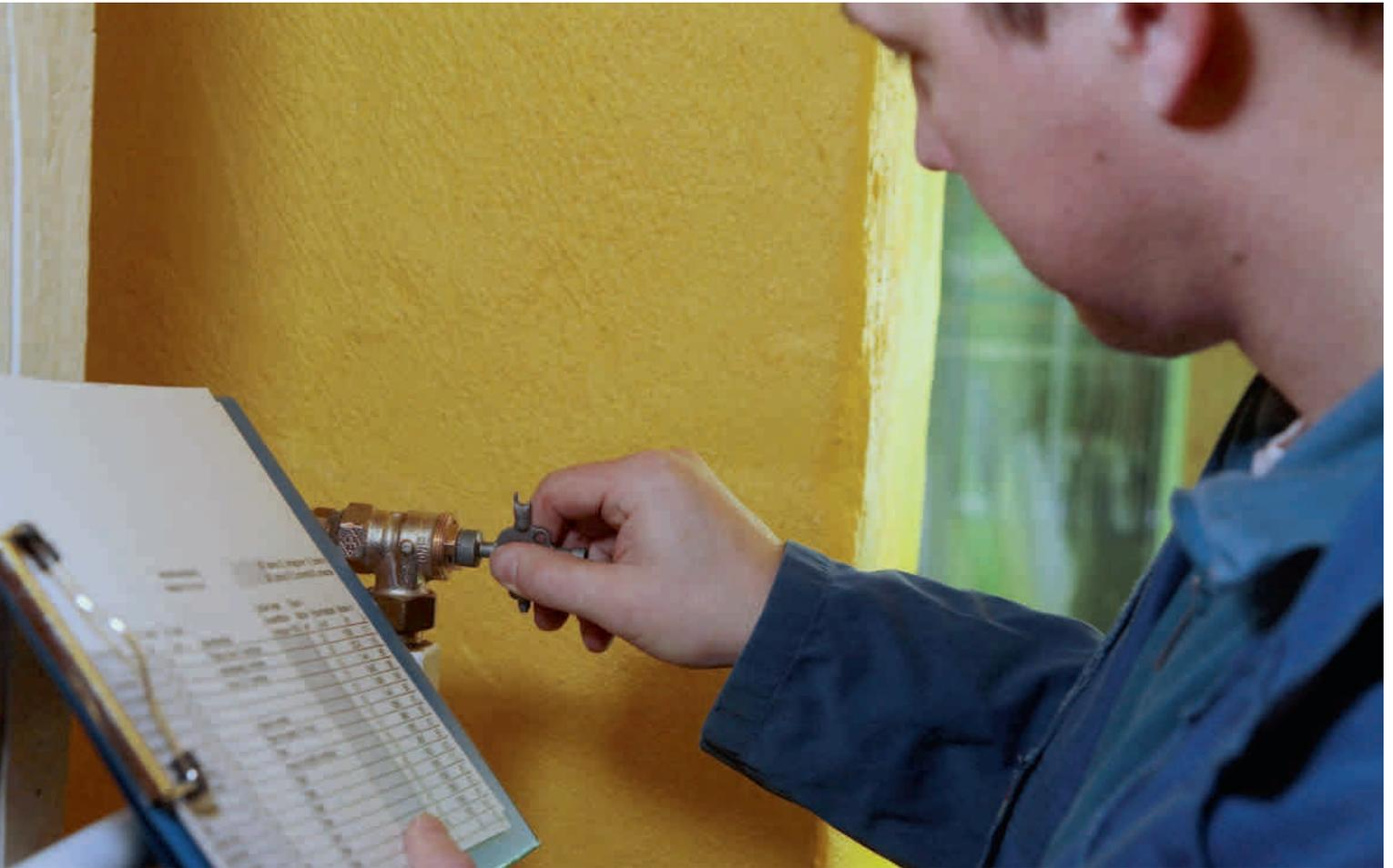
Das Einstellen des Thermostatventils beim hydraulischen Abgleich sichert den effizienten Betrieb von Brennwertkesseln. FOTO: WWW.CO2ONLINE.DE/ALOIS MÜLLER
