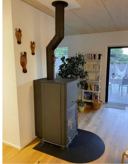
Stückholzofen mit Heizwasser-Register im Erdgeschoss: Typ «Phönix» von Powall, für Stückholz 33 cm, Leistung bis 17,7 kW.
