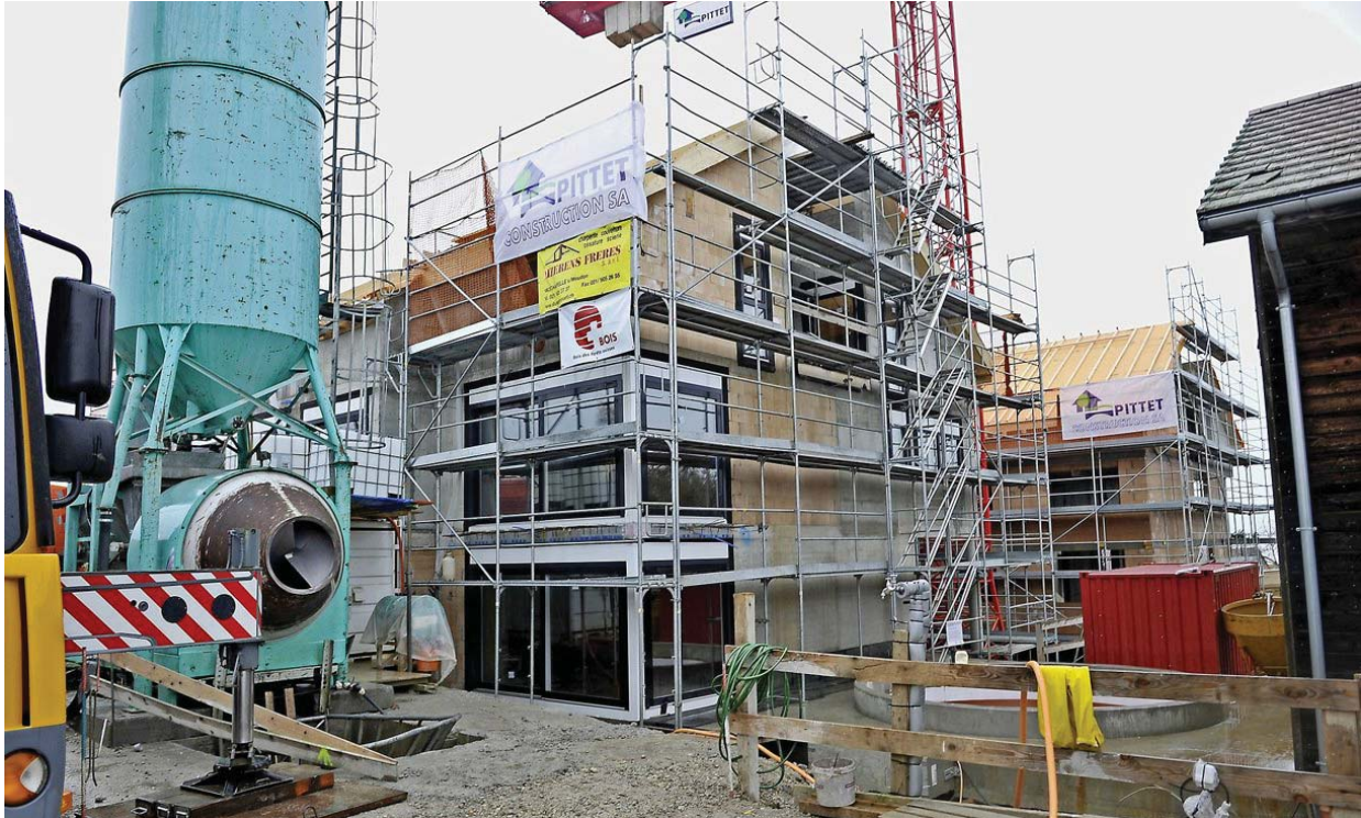
Les quatre petits immeubles en cours de construction utilisent des techniques traditionnelles mais seront équipés de tous les moyens possibles pour produire de l'énergie.
