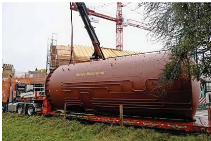
Le réservoir de 85 000 litres, soit trois semaines de consommation, centralisera toute l'eau chaude du quartier.
