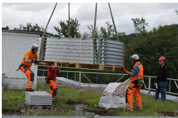
*Die Kollektoren wurden mit dem Helikopter vom Lastwagen aufs Dach transportiert und dort installiert.*
