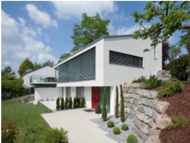
Abb. 7: Netto-Plusenergiehaus mit 260 m 2 von Prof. Dr. Fisch in Leonberg, Wärmepumpe, 15 KWp Photovoltaik, 7 m 2 Solarthermie, Akku 7 kWh, Messungen 2011: Stromverbrauch 9.027 kWh/a, solare Deckungsrate 32%, 62 kWh/m 2 a Primärenergieverbrauch, Baukosten etwa 945.000 € , Bildquelle: www.heinze.de
