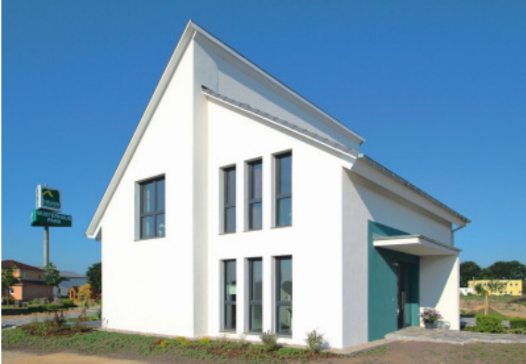
Abb. 14: Nordostansicht [Quelle: HELMA Eigenheimbau AG]
