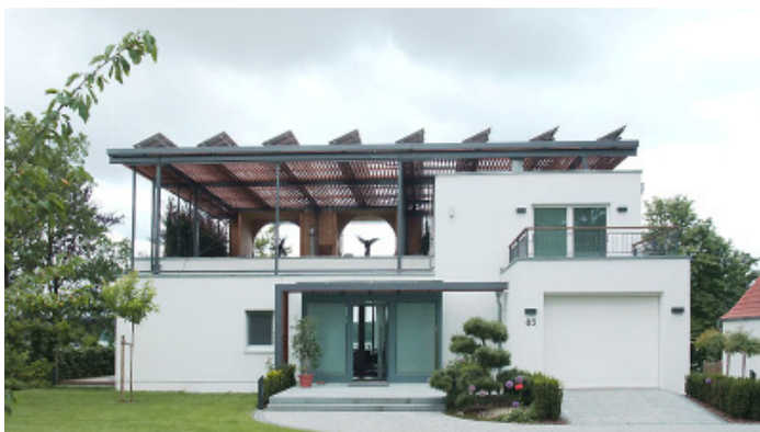
Abb. 6: Energetisches Aktivhaus (Plusenergiehaus) mit Photovoltaik und gebäudeintegrierter Windkraftnutzung in Bad Saarow Dr. Bodo Wolf BW Energiesysteme GmbH, Baukosten ? € , Bildquelle: EA EnergieArchitektur GmbH
