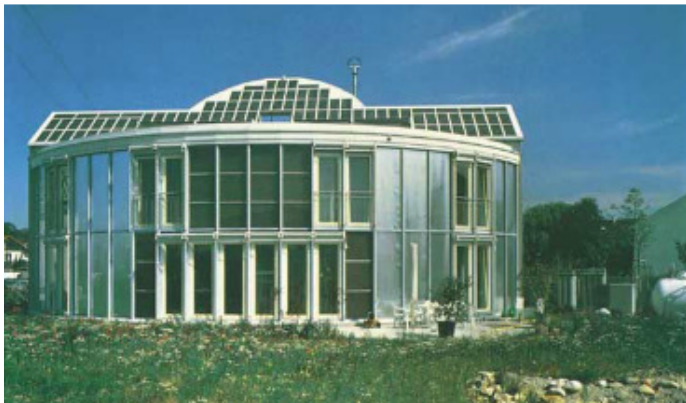
Abb. 5: energieautarkes Solarhaus in Freiburg, Baukosten etwa 1.400.000 € , Bildquelle: www4.architektur.tu-darmstadt.de
