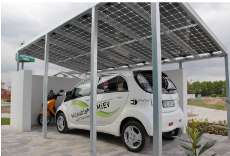
Abb. 18: Elektromobilität am energieautarken Haus.
