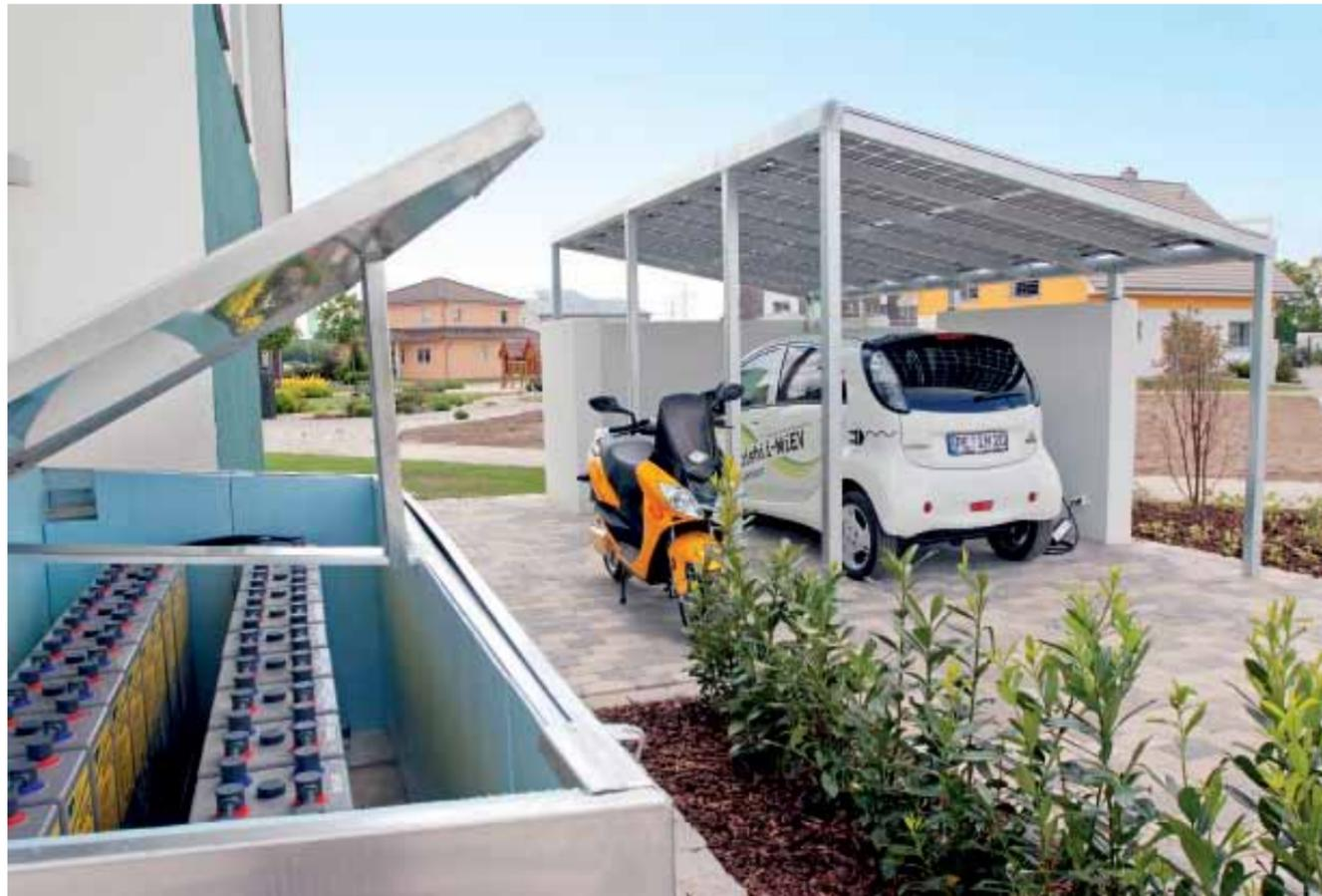
In der mit Aluminium verkleideten Box an der Hauswand befindet sich ein Elektroenergiespeicher, in dem der überschüssige Strom für die spätere Verwendung gespeichert wird. Auf dem Dach des filigranen Carports kamen lichtdurchlässige Photovoltaikmodule zum Einsatz, aus deren Ertrag das Elektroauto geladen wird.
