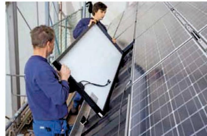
Nach Abdeckung und Dämmung des Dachstuhls werden auf dem Süddach 46 Quadratmeter Solarkollektoren zur Wärmeversorgung und 58 Quadratmeter Photovoltaik-Elemente zur Stromerzeugung montiert.
