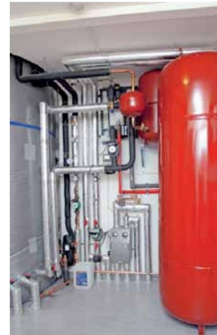
Die Heizungsanlage im Hauswirtschaftsraum (HWR) ist mit dem Solarspeicher verbunden und sorgt für die Verteilung von Wärme und Warmwasser.
