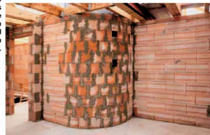
Aufgrund der schlechten Witterungsverhältnisse zur Bauzeit wurde der Bauplatz in ein beheiztes Allwetterzelt gehüllt, bevor die massiven Wände aus gedämmten Hochlochziegeln errichtet wurden.
