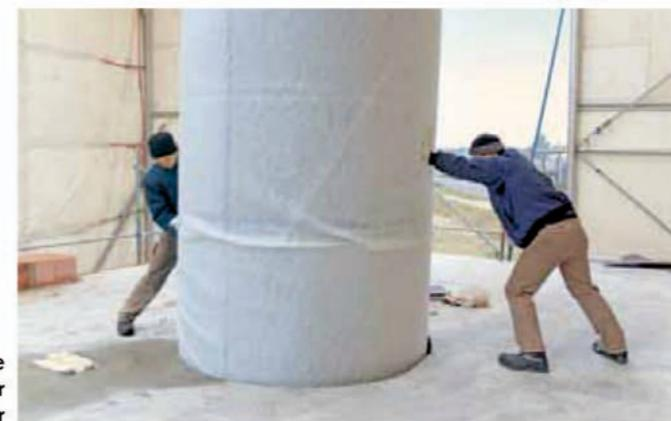
Der zylinderförmige Langzeit-Solarspeicher erstreckt sich mit einer Höhe von 7 Metern vom Erdgeschoss bis unters Dach. Das runde Volumen wird in den Grundriss integriert und so zum gestalterischen Element im Haus.
