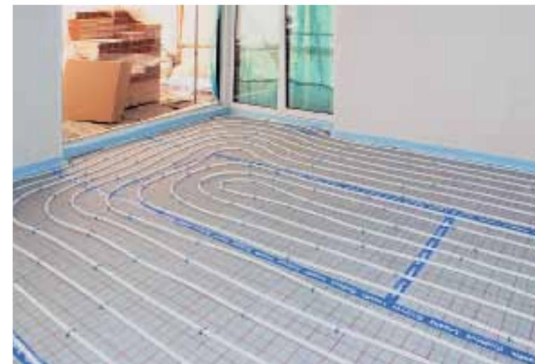
Fußbodenheizung, die im ganzen Haus verlegt wurde, sorgt für eine gleichmäßige Verteilung der Wärme und somit für ein hohes Maß an Behaglichkeit. Dank der Strahlungswärme, die besonders angenehm ist, findet keine Staubaufwirbelung statt. Zudem kann die Temperatur niedriger gehalten werden, was Energie spart.
