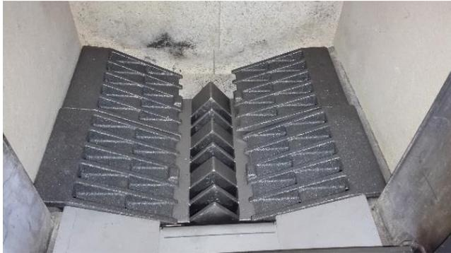
Nach der Reinigung werden die Gussteile, der Schamotte hinter dem Injektor und die Abdeckung des Querkanals wieder eingelegt.
