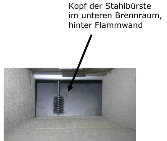
**Wichtig:** Die Bürste immer bis ganz nach unten durchstoßen (siehe Bild oben), damit man sie ohne große Mühe wieder nach oben ziehen kann und wirklich der gesamte Kanal gereinigt wird. Wenn die Bürste ganz durchgestoßen ist, ist diese im unteren Brennraum zu sehen.
