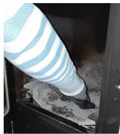
Nun werden die Luftwege frei gelegt, hierfür wird die Asche in den unteren Brennraum gekehrt.
