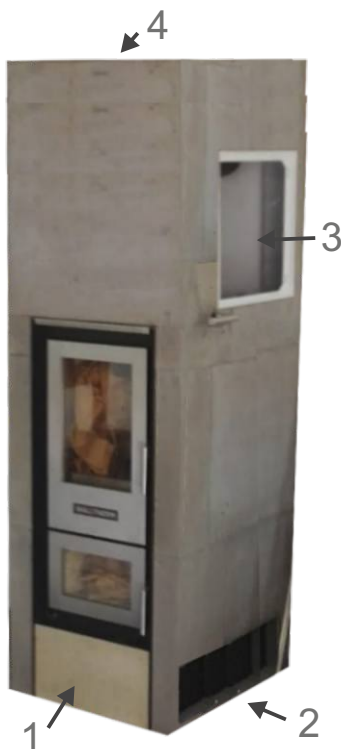
Ummauerung mit feuerfester Kaminbauplatte.
