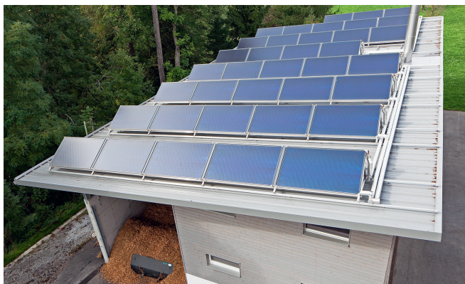
Anlage Enko AG, Müswangen LU, heizt auf einen 20000-Liter-Jenni-Speicher für einen Schnitzel-Fernwärmeverbund. Solarkollektoren von Ernst Schweizer AG, Metallbau.
