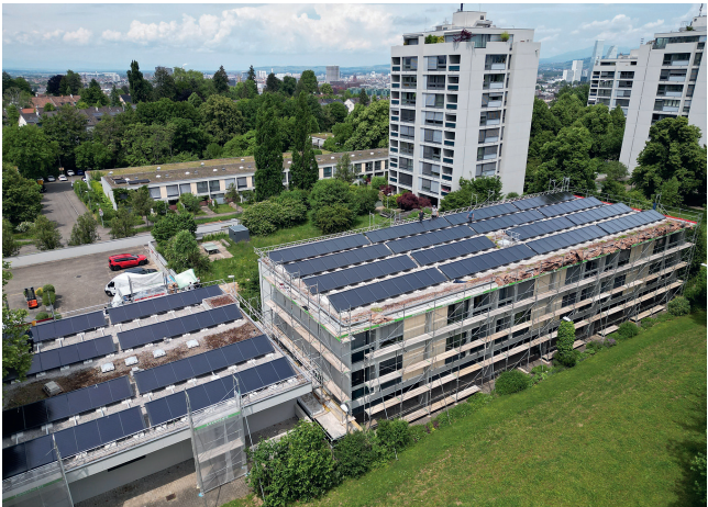
Sesselacker Basel: 320 m² Kollektoren und vier Jenni-Speicher à 12 000 Liter Nutzinhalt (Platzschweissung).
