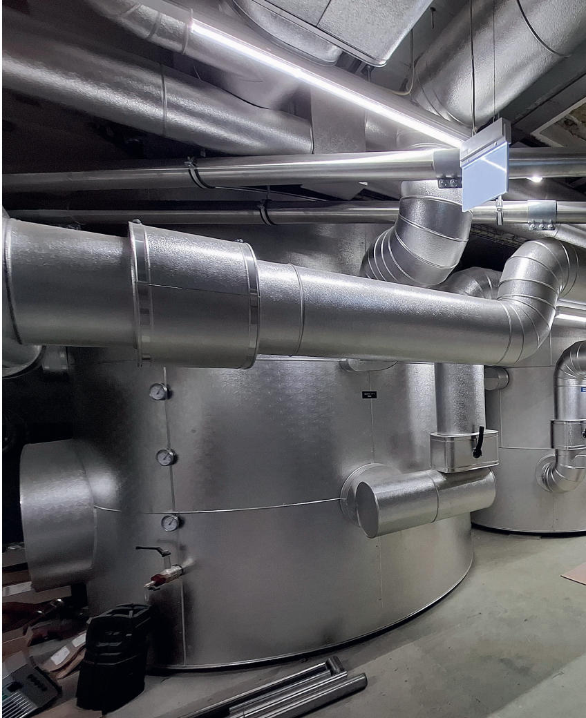
Sesselacker Basel: 320 m² Kollektoren und vier Jenni-Speicher à 12 000 Liter Nutzinhalt (Platzschweissung).
