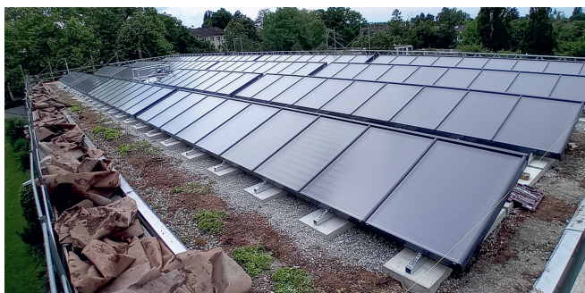
Anlage Sesselacker Basel, 320 m 2 Solarkollektoren Winkler VarioSol A.
