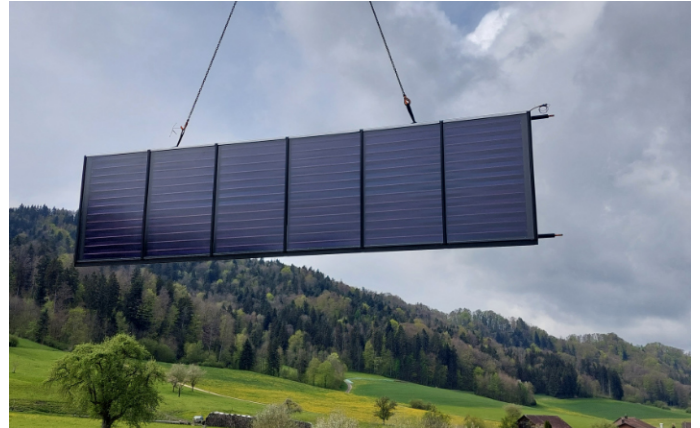
Wir liefern mit dem Kran auf's Dach: Montage einer Solarthermieanlage in der Ostschweiz
