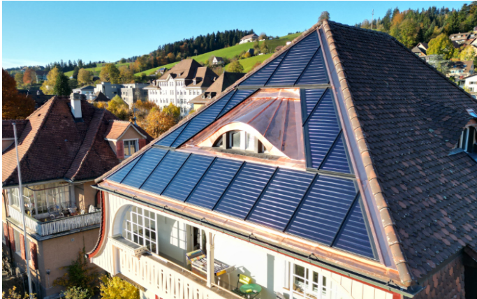
Erfolgreich realisierte Indach-Solarthermieanlage auf Mehrfamilienhaus, 40 % Wärme von der Sonne in Langnau i. E., 19 m 2 und 1'920 Liter Swiss Solartank®
