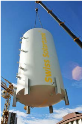
66 000 Liter Kältespeicher, Umweltarena Spreitenbach
