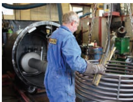
Wärmetauscher, Boiler und Stützen werden angeschweisst.
