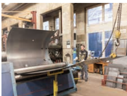
Der Speichermantel wird gerundet.
