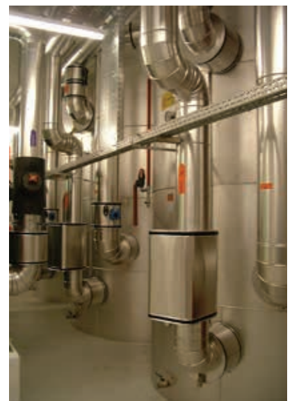
Spezialisolationen (z.B. mit Alumantel oder für Kältespeicher)
