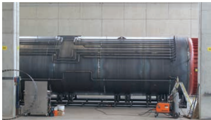
In Arbeit: Solarspeicher mit angeschweisster Verrohrung
