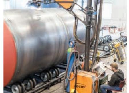
Zusammenschweißen der Mantelteile und aufsetzen von Speicherdeckel und -Boden.
