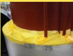
Für Sonnenhäuser mit hohem solaren Deckungsgrad, für welche Wärme über längere Zeit gespeichert werden soll, bieten wir hochisolierte Speicher (200 bis 300 mm) an. In die Speicherisolation wird ein Ballonstoff eingearbeitet, um eine vertikale und horizontale Kammerung zu erreichen. Zudem sind siphonierte Anschlüsse bei solchen Speichern sehr wichtig. Alle diese Massnahmen tragen zu einer verbesserten Schichtung bei.
