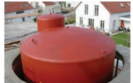
**Warmwasser-Glocke** für optimale Energienutzung im Boilerbereich (ab 1.7 m Speicher-Durchmesser).
