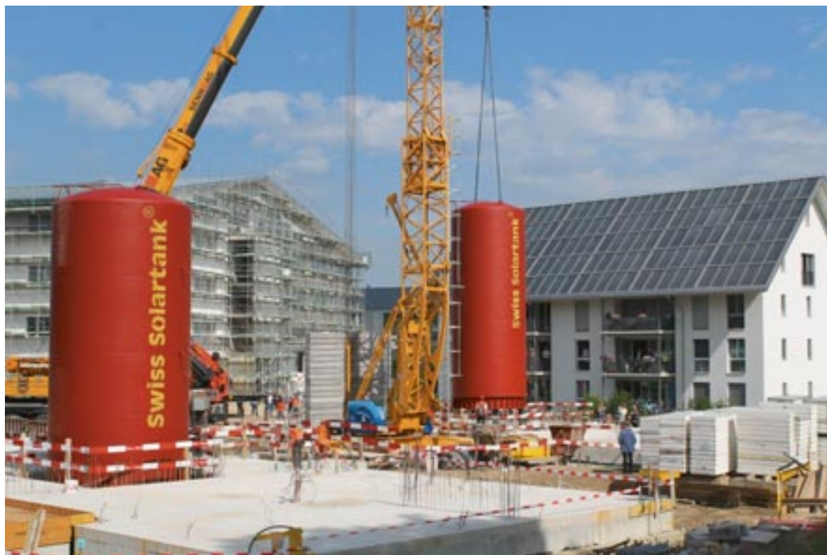
Erst kommt der Speicher, dann wird das Haus herum gebaut.
