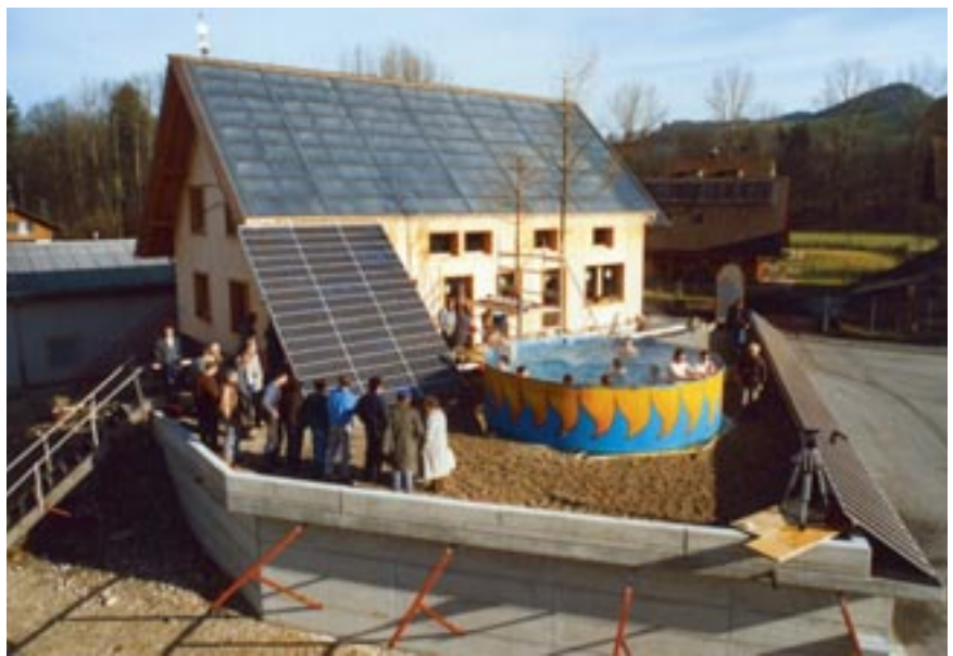
Auf der Südseite des Sonnenhauses in Oberburg wurden 84 m 2 Solarkollektoren und 43 m 2 Photovoltaik installiert. Am 31. Januar 1990 war der solar beheizte Pool ein Spektakel, das die Popularität der Solarenergie enorm steigerte.
