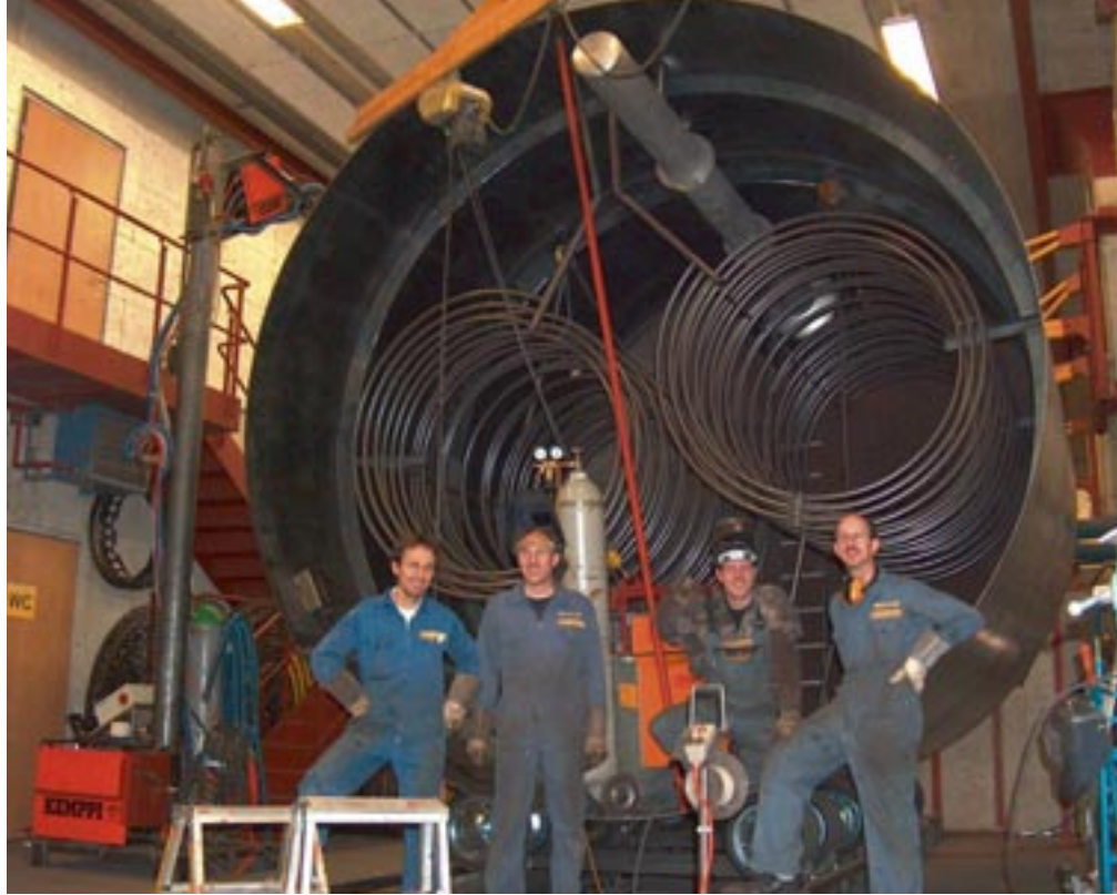
Der Speicher des ersten vollständig solarbeheizten Mehrfamilienhaus hat ein Volumen von 205 m 3 .
