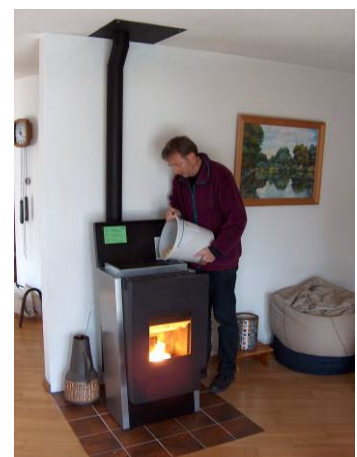
Füllen des Stubenkessels
