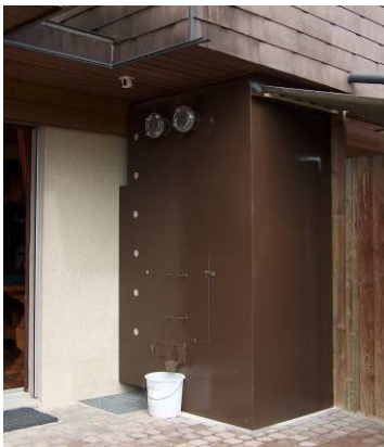
Lagertank mit 2 Tonnen Inhalt
