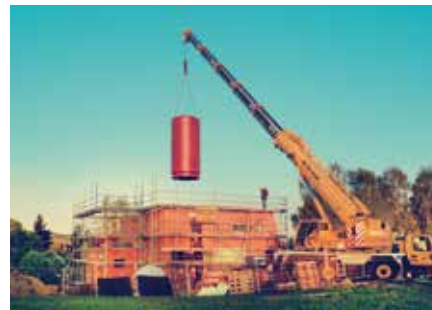
Ein wichtiger Bauabschnitt: Speichersetzung. Der Ganzjahressolarspeicher wird per Autokran in das Gebäude eingehoben.
