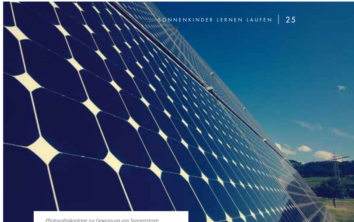
Photovoltaikanlage zur Gewinnung von Sonnenstrom
