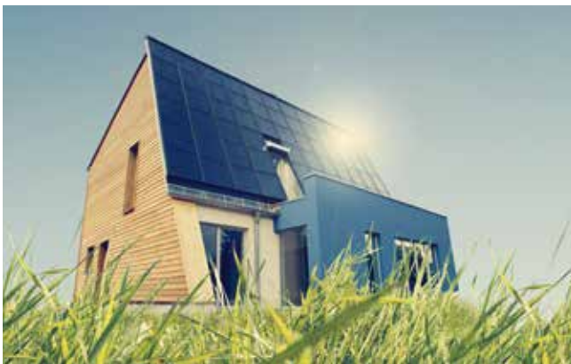
Das erste ENERGETIKhaus100® in Berthelsdorf bei Freiberg
