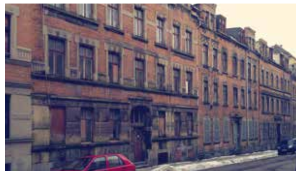
Kanalstraße 15 & 17, Fassade vor der energetischen Sanierung
