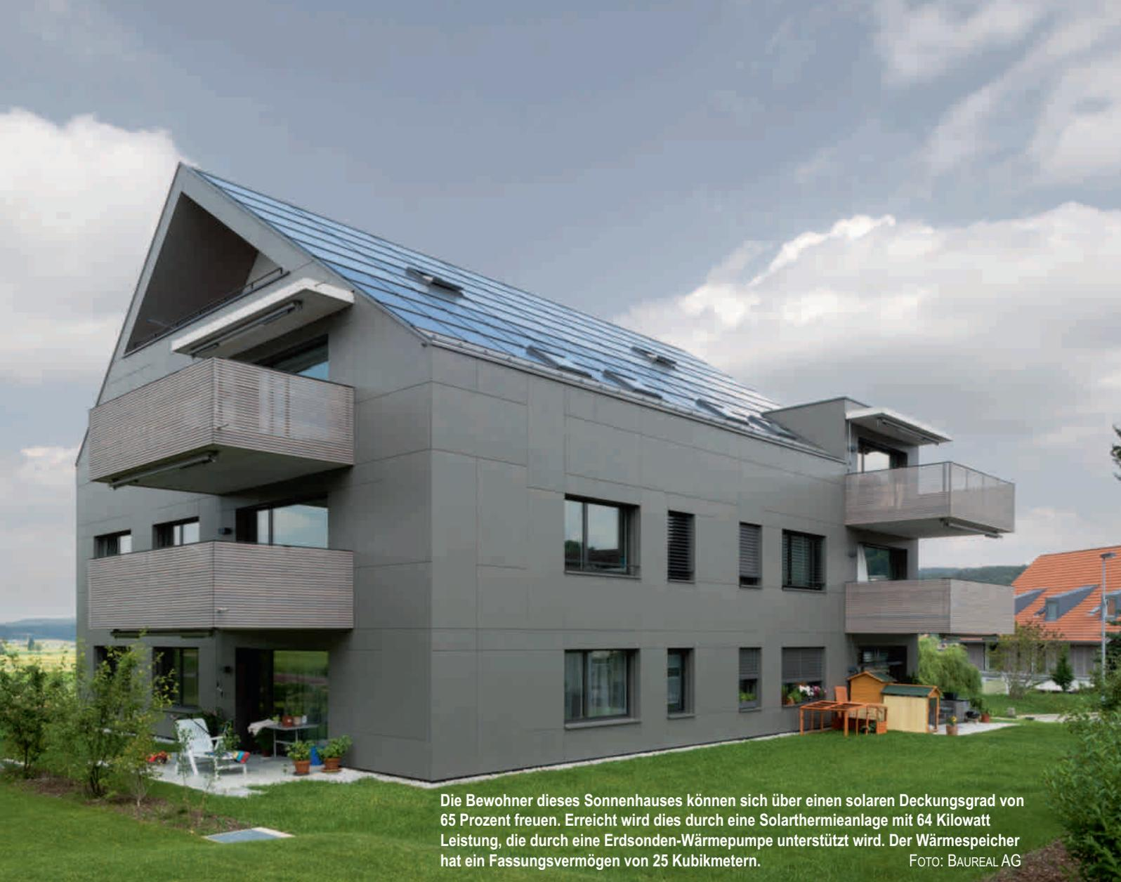
Die Bewohner dieses Sonnenhauses können sich über einen solaren Deckungsgrad von 65 Prozent freuen. Erreicht wird dies durch eine Solarthermieanlage mit 64 Kilowatt Leistung, die durch eine Erdsonden-Wärmepumpe unterstützt wird. Der Wärmespeicher hat ein Fassungsvermögen von 25 Kubikmetern.
